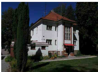
Budova pelhřimovského Fokusu
